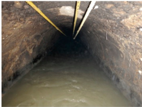
Colector 60"Ø desazolado para su rehabilitación.
