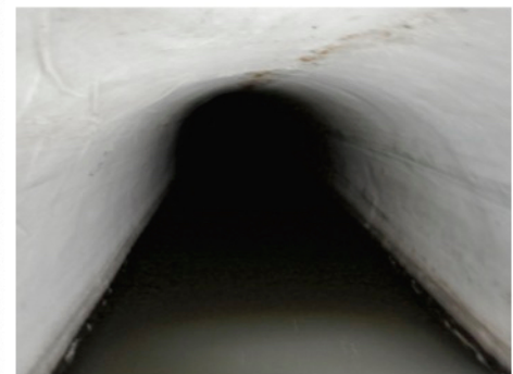
Colector #8 Rehabilitado por método CIPP.
